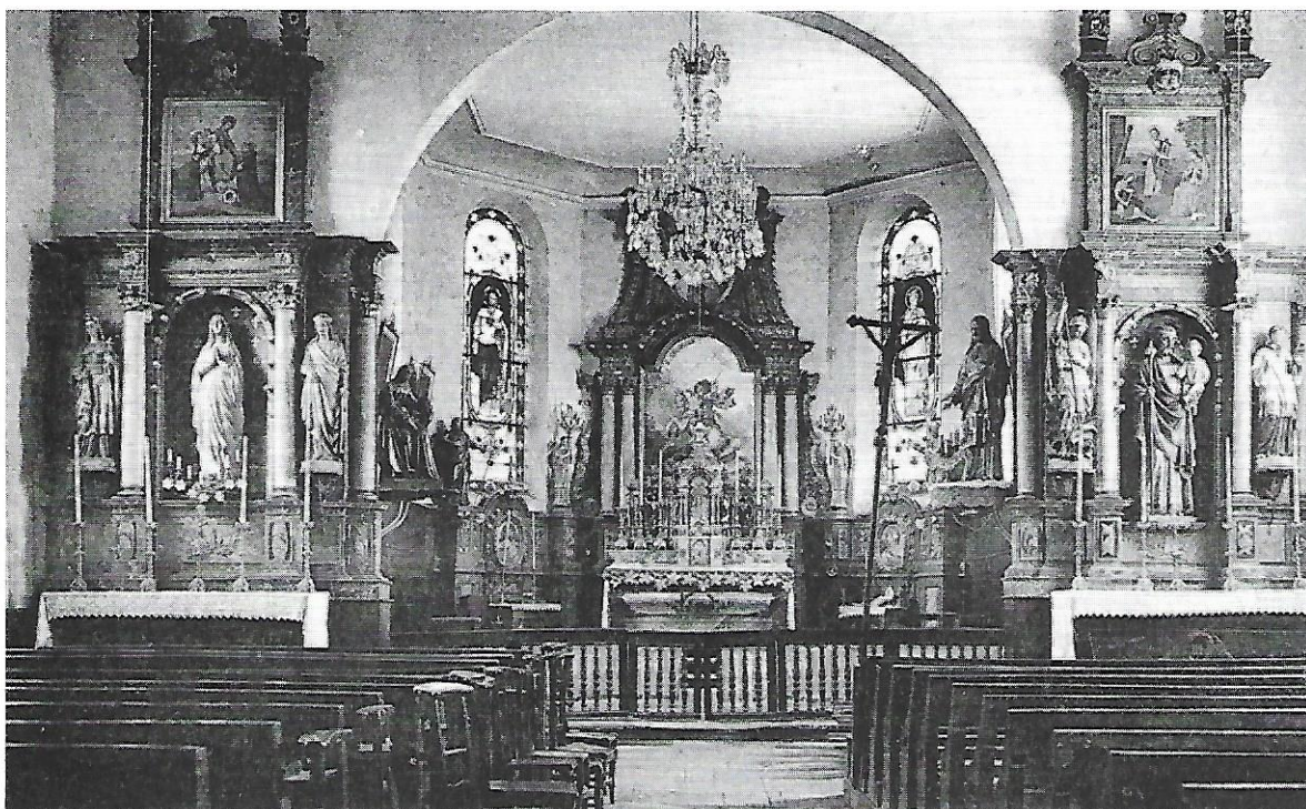
Intérieur de l'Église avant les travaux de 1931.
